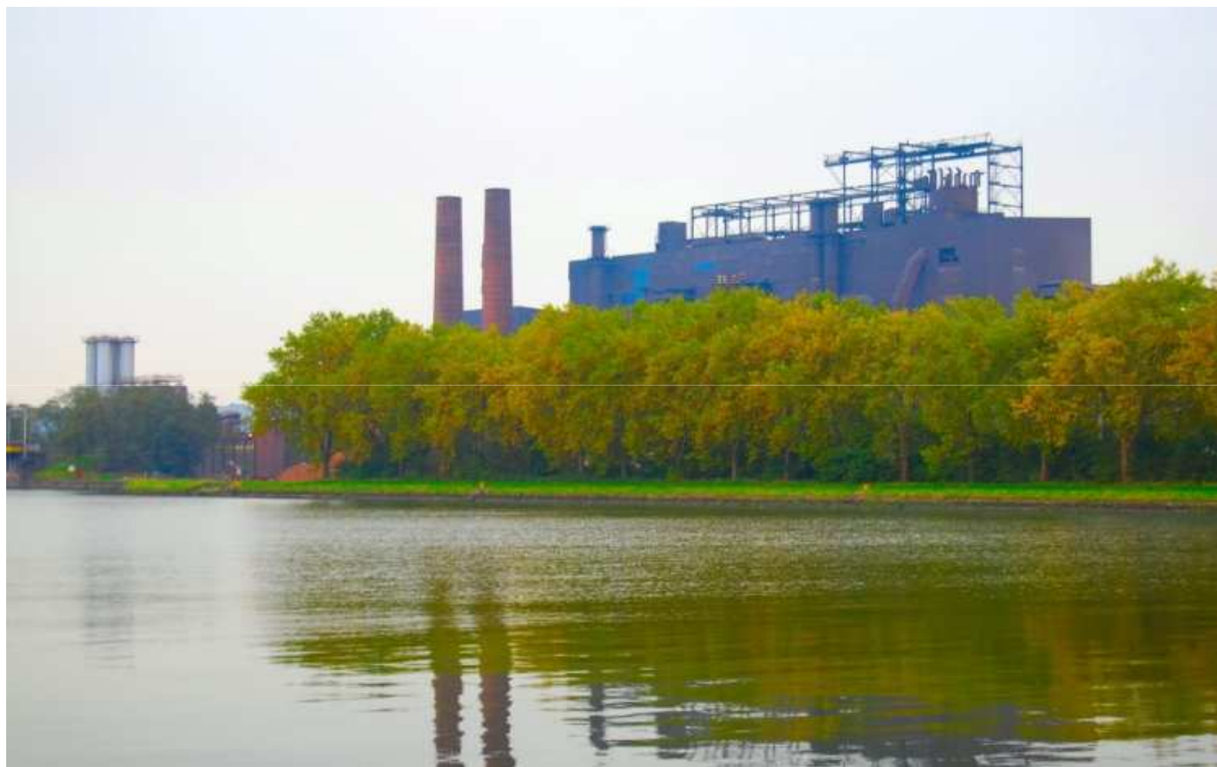
© Georges Meurice Usine métallurgique de Chertal, Belgique Octobre 2007 INERIS
